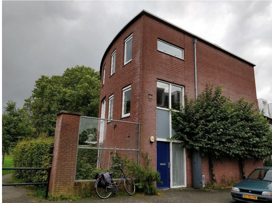
Afbeelding 1: voor- en zijgevel van de woning
